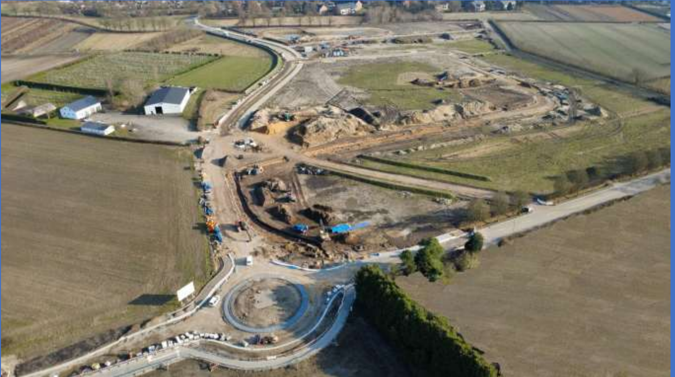
Das sich in der Erschließung befindliche Gewerbegebiet an der Tangstedter Chaussee am 9. März 2026. Im Vordergrund der neue Kreisels, über den die künftige Käthe-Schaller-Straße an die Tangstedter Chaussee angebunden wird: Foto: Gemeinde Rellingen
